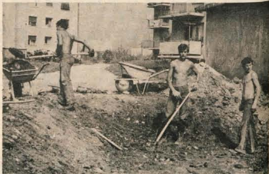
Prebivalci Plavža na Jesenicah se večkrat upravičeno razburjajo nad neurejenostjo površin med bloki, ki so bili zgrajeni med prvimi. Zdaj pa se stvari izboljšujejo, saj okolico urejajo. Delavci SGP Sava Jesenice urejajo okolico garažne hiše, ki so jo pred kratkim zgradili ob Cesti revolucije na Spodnjem Plavžu. – Foto: B. B.
