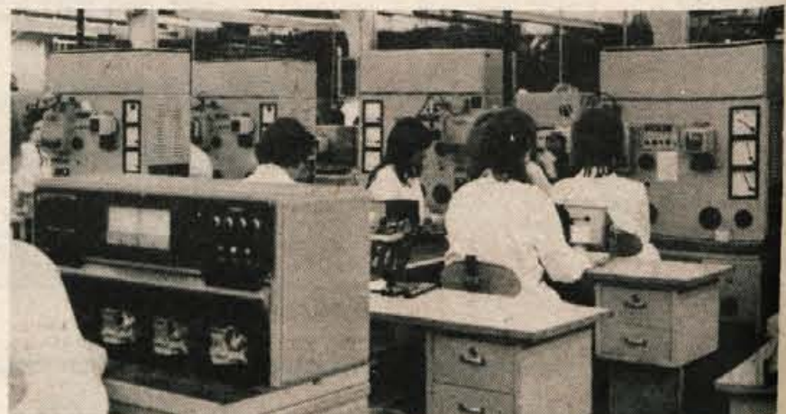
Montažni trak enofaznega električnega števca v Tovarni števec Kranj
