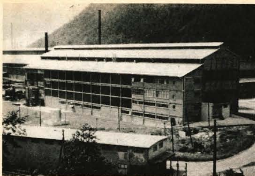
V Železarni so se odločili, da začnejo z izdelavo kovinskih vratnih podbojev, za katere je na tržišču precejšnje povpraševanje. Kovinske vratne podboje izdelujejo v prenovljenem obratu na Javorniku. Foto: D. S.
