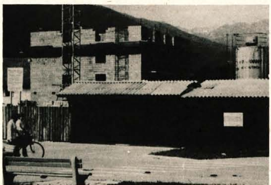
Delavci gradbenega podjetja Bohinj grade v Bohinjski Bistrici že četrti štirnadstropni stolpič, v katerem bo 20 stanovanj. Blok so začeli graditi pozimi, stanovanja pa bodo nared za vselitev v začetku prihodnjega leta. Stanovanja bodo odkupile različne delovne organizacije, nekaj pa tudi solidarnostni sklad radovljiške občine. - B. B.
