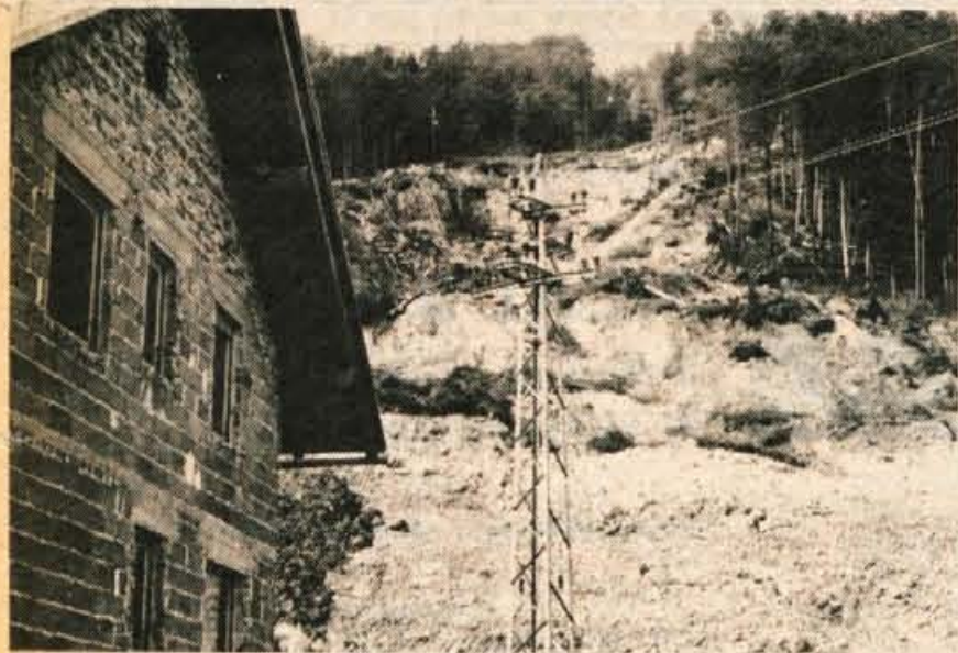
Na Blejski Dobravi so začeli odstranjevati posledice zemeljskega plazju, ki je ogrozil nekaj hiš tako, da so se prebivalci morali začasno odseliti. Cesta na Blejsko Dobravo, na katero se je zgrnil zemeljski plaz, pa še vedno ni prevozna in zato poteka promet po obvozni poti. Foto: D. S.
