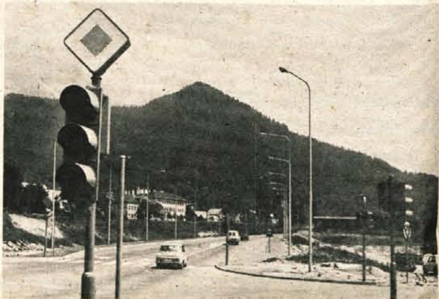
Na Koroški Beli so uredili samaforizirano križišče, ki bo začelo delati takoj potem, ko bodo popolnoma uredili cestne odseke proti novi hladni valjarni na Beli. Foto: F. Perdan
