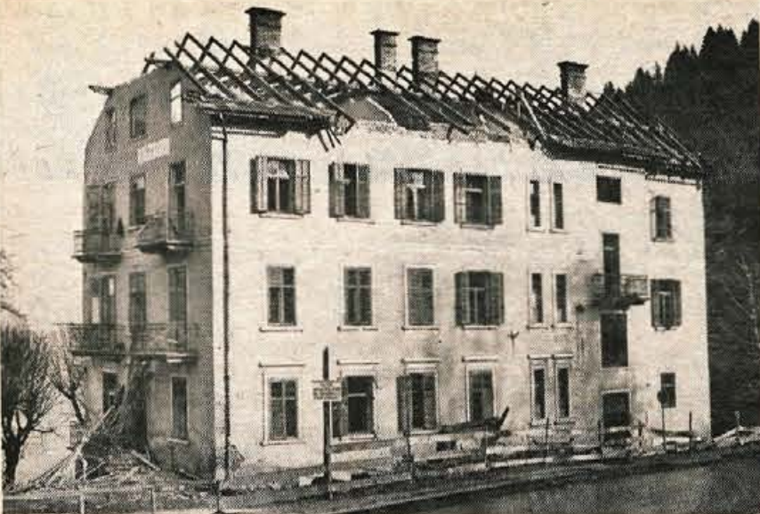
Pred dnevi so v naselju Mlino na Bledu začeli podirati nekdanji hotel Petran. Hotel Petran je bil eden prvih hotelov na Bledu in je bil znan predvsem med obema vojnama. Po zadnji vojni so zaradi dotrajanosti objekta hotelsko dejavnost v njem opustili; vanj so se vselile številne družine. Zadnja leta pa je bilo bivanje v teh stanovanjih že kar nevarno. Zato je bila rušitev te stavbe več kot potrebna. — A. Ž. — Foto: F. Perdan
