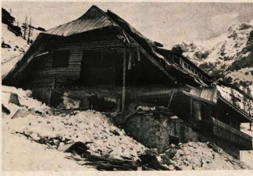
Jeseniški planinci čistijo okolico poškodovanega doma in ga pripravljajo za obnovo.
