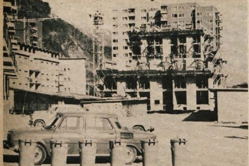
SGP Sava Jesenice gradi na Jesenicah dve stolpnici, v katerih bo po 52 stanovanj. Stolpnici bosta predvidoma vseljivi v začetku zime. – Foto: B. B.
