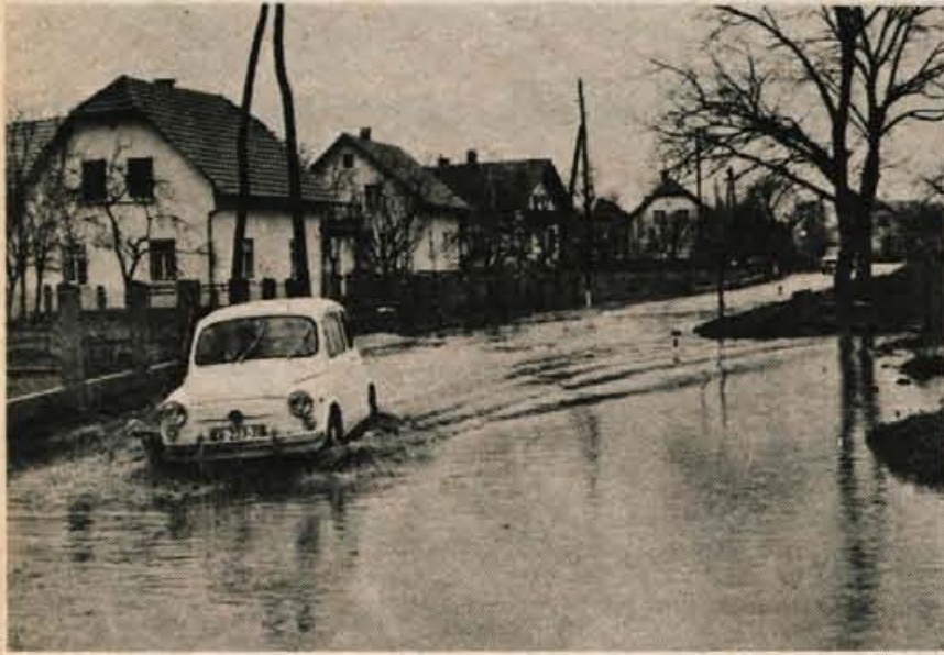
Ob količkaj večjem deževju voda zalije lep del ceste proti Golniku na Mlaki, kar povzroča voznikom precej preglavic, pogosto pa je bajer na cesti vzrok za prometne zastoje. Ker voda nima kam odteči, so si med zadnjim deževjem pomagali kar s kmečko cisterno, opremljeno s črpalko. (jk) – Foto: F. Perdan
