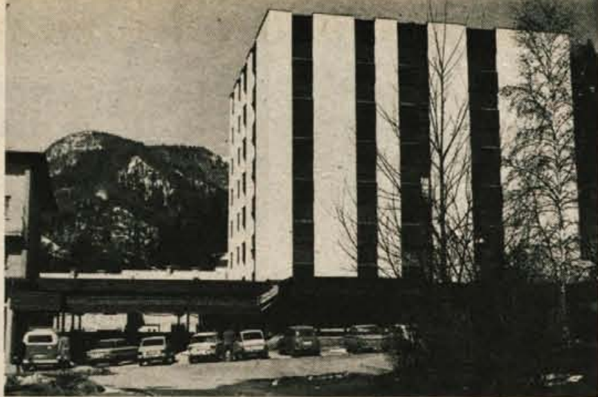
SGP Sava je na Koroški Beli poleg samopostrežne trgovine Zarja zgradilo nov stolpič, v katerem bodo prebivali delavci, ki bodo sodelovali pri gradnji nove hladne valjarne na Beli. V spodnjih prostorih pa bodo prostori za družbeno prehrano. — Foto: F. Perdan
