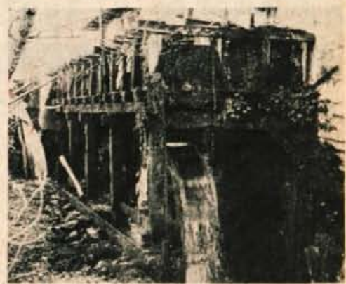
Rake in vodna kolesa brdskega mlina v Predosljah; med večjimi vodnimi mlini v naših krajih, gotovo eden poslednjih...
