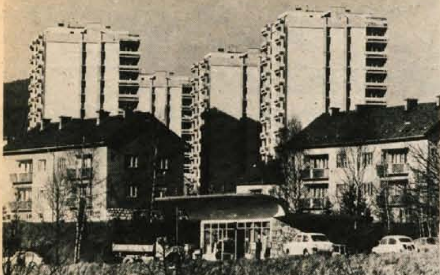
Po zaslugi SGP Tehnik so v Škofji Loki lani dobili 162 novih stanovanj ter usposobili kanalizacijsko mrežo, dolgo skupno 5773 metrov
