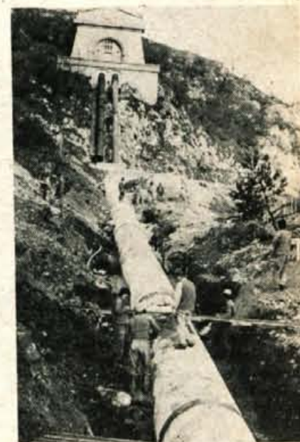
Za elektrarno Završnica grade novo polovico debelejšega tlačnega voda. Foto: B. B.
