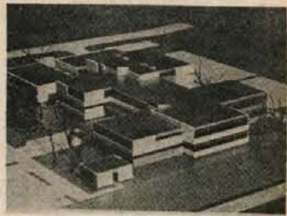
Maketa novega poslopja za slovensko gimnazijo v Celovcu. — Stavba je še vedno v surovem stanju. Dela le počasi napredujejo.
