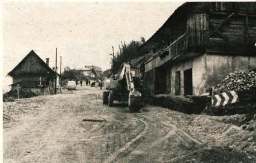
Delavska cesta bo modernejša in povezana z Gorenjesavsko cesto.
