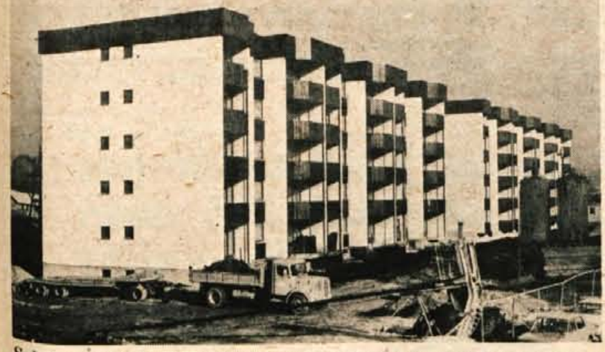
Splošno gradbeno podjetje Gorenje gradi v Radovljici v blokih stanovanja za prodajo in iz sredstev solidarnostnega stanovanjskega sklada. Lani novembra sta bila zgrajena in useljena dva bloka. Sredi tega tedna pa bo gotov še en blok, v katerem je 40 stanovanj, enak drugi blok pa bo gotov čez mesec dni. V obeh blokih bodo dobili stanovanja kupci in najemniki iz solidarnostnega stanovanjskega sklada. — A. Z. — Foto: F. Perdan
