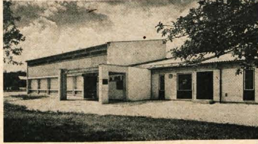
Ena izmed gradenj kamniškega Graditelja: šola v Stranjah.
