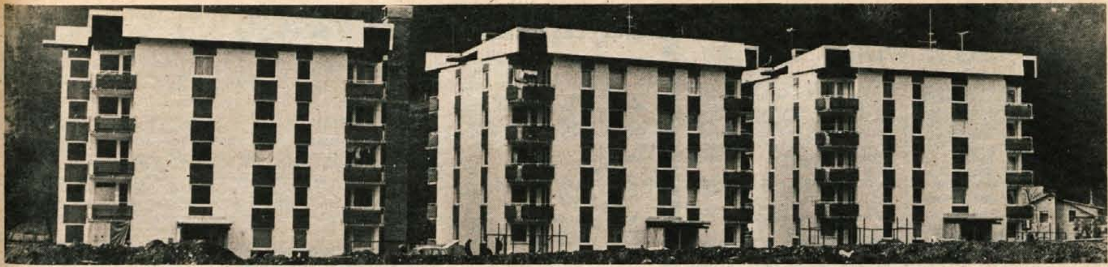
Novi stanovanjski bloki v Bistrici pri Trzinu sprejemajo ta mesec prve stanovalce. Nekaj stanovanj je bilo zgrajenih tudi s sredstvi solidarnostnega sklada. Letos bo vseljivih 20 stanovanj, spomladi pa prav toliko — Foto: F. Perdan
