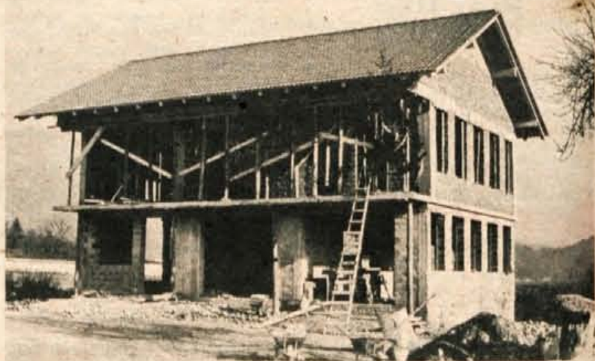
Novi dom Avto-moto društva Cerklje je pod streho! Pokrili so ga preteklo nedeljo, ko je v udarniški akciji sodelovalo okrog 30 članov društva. Letos nameravajo v novem domu napeljati instalacije in urediti del pročelja, druga dela pa bodo počakala prihodnjega leta. (jk) — Foto: F. Perdan
