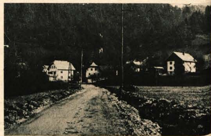
Prebivalci dela krajevne skupnosti Poljane v Poljanski dolini so se letos na referendumu odločili za plačevanje samoprispevka za ureditev ceste Poljane—Hotovlje—Viharje. Vsa pripravljena dela pred polaganjem asfaltne prevleke, širjenje cestišča ter postavljanje skarp in opornih zidov, so v glavnem končana in so ocenjena na vrednost okrog 450.000 din. Večino del so občani s tega področja opravili s prostovoljnim delom. Odsek v dolžini približno 2,5 kilometra bo asfaltno prevleko dobil že prihodnje leto. Seveda bo za to potrebnega še precej denarja, zato prebivalci, ki so vezani na to cesto, upravičeno pričakujejo tudi pomoč občinske skupščine in delovnih organizacij. (v.jg) — Foto: F. Perdan
