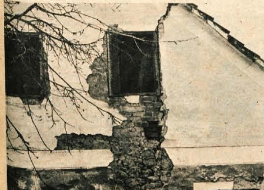
Potresni sunki so krepko razmajali hišo Joška Hrovata iz Serovega nad Šmarjem. Obodne stene so se nagnile in pojavile so se grozeče razpoke.
