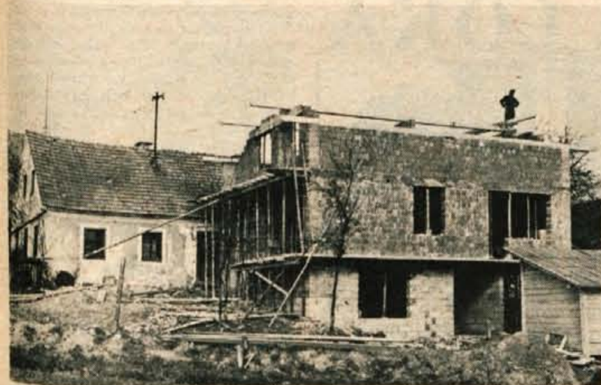
Ena od novih hiš, ki so jih zgradili gorenjski gradbinci na Kozjanskem. Pri tej so opravili glavna dela Projektovci, temelje in streho pa je pripravil lastnik Joško Hrovat sam. »Žal je načrt tak, da z 20 milijoni posojila ne bom prišel skozi. Vložiti bom moral še precej lastnega denarja in dela,« pravi priletni kmet Joško Hrovat.
