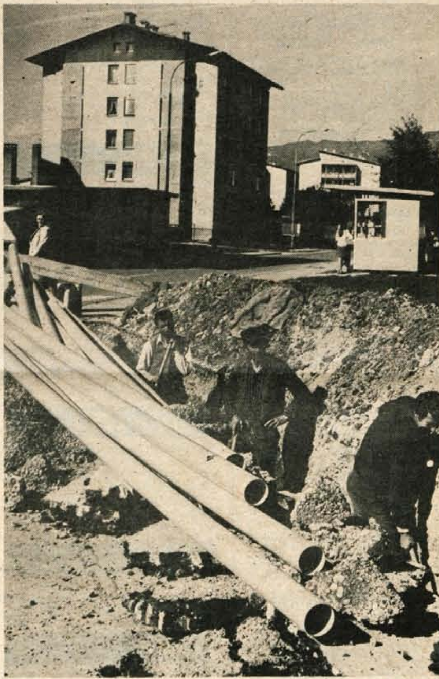
Podjetje za PTT promet Kranj te dni v skladu z razvojem nekaterih naselij v kranjski občini povečuje zmogljivosti za telefonsko mrežo. Z deli hitijo, da jih ne bi presenetilo slabo vreme. — A. Z. — Foto: F. Perdan
