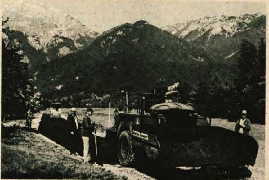
Delavci Cestnega podjetja iz Kranja so začeli pretekli četrtek vgrajevati asfalt na cesti med Zgornjo Belo in Bašljem. Z asfaltom so prekrili 1700 metrov dolgo makadamsko cestišče od mostu na Zgornji Beli do križišča na vrhu klanca v Bašlju. (jh) — Foto: F. Perdan
