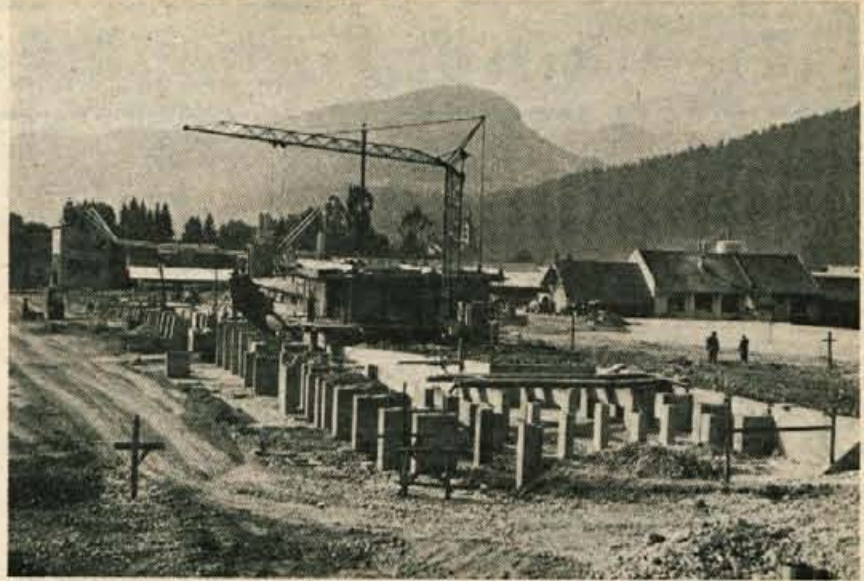
Lesno industrijsko podjetje Bled — obrat Tomaž Godec in Gozdno gospodarstvo Bled gradita v Bohinjski Bistrici novo lupilnico oziroma obrat za obdelavo lesa ter skladišče. Z deli so začeli maja letos, proizvodnja v novem obratu pa bo stekla konec leta. Gradnja nove lupilnice bo veljala prek 20 milijonov novih dinarjev in bo vsako podjetje prispevalo polovico. Izvajalec del pa je Gradbeno podjetje Bohinjska Bistrica. — A. Ž. — Foto: F. Perdan
