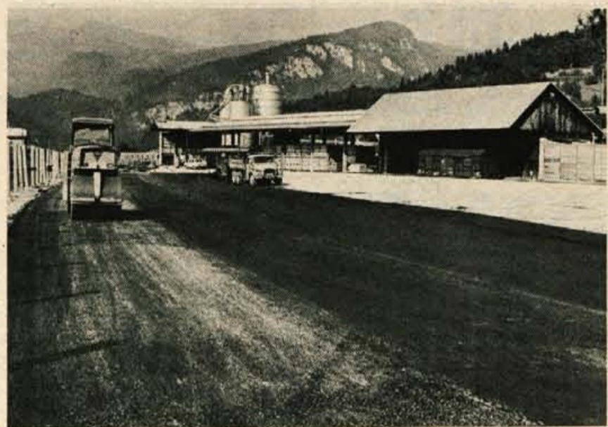
Cestno podjetje iz Kranja je minuli teden asfaltiralo skladišče Gozdnega gospodarstva Bled — gozdne uprave v Bohinjski Bistrici. Gozdno gospodarstvo bo imelo na okrog 6000 kvadratnih metrih površine skladišče za droben les in drva, izdelovali pa bodo tudi tramiče. Celotna investicija bo veljala okrog 2 milijona dinarjev. — A. Ž. — Foto: F. Perdan
