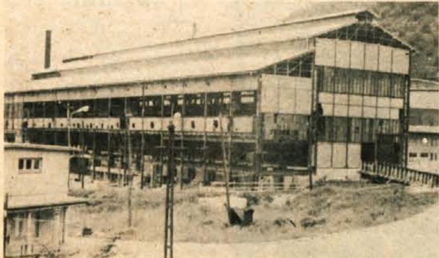
Obrot, ki ga vidimo na sliki, je bil svojčas generatorska hala Železarne Jesenice na Javorniku. Glede na to, ker so v jeseniški Železarni prišli pri ogrevanju od generatorskega plina na mazut, to veliko halo preurejujejo v obrat za serijsko izdelavo vratnih podbojev. S poskusnim izdelovanjem podbojev so že začeli. Ob koncu leta, ko bo to veliko postopje preurejeno, pa bo stekla tudi serijska proizvodnja. — B. B.
