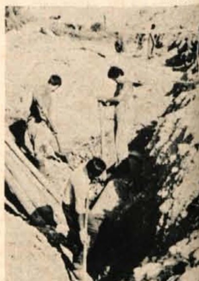
Delavci splošnega gradbenega podjetja Sava nadaljujejo z gradnjo jeseniškega vodovoda, ki bo dovajal vodo iz Peričnika. Skupno z delavci podjetja Vodovod Jesenice so v prvi etapi položili cevi od Peričnika do Mlak, v drugi etapi so lani opravili delo do Kureja na Hrušici, letos pa nameravajo položiti cevi do glavnega zbiralnika na Pejcah.
