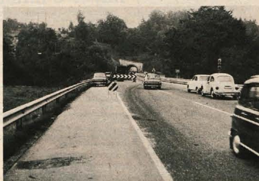
Cestno podjetje iz Kranja je konec minulega tedna na viaduktu Ljubno na gorenjski cesti popravilo diletacijo — vezno ploščo, ki omogoča, da se mostna konstrukcija ob različnih vremenskih prilikah lahko razteza ali krči. Ploščo, ki se je zlomila, so zavarili. Menijo pa, da bodo tudi na tem odseku morali čez čas ugraditi enako napravo, kot so jo v začetku leta na viaduktu Peračica. — A. Ž.
