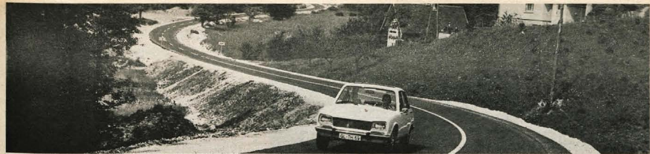
Pretekli teden je bila odprta za promet modernizirana cesta med Seničnim in Golnikom. Glavna gradbena dela so končana. Cestno podjetje iz Kranja mora urediti še bankine in odvodne jaskhe. Modernizacijo ceste je financirala Skupnost za ceste SRS. Vrednost letos opravljenih del znaša 6.600.000 dinarjev — Foto: F. Perdan
