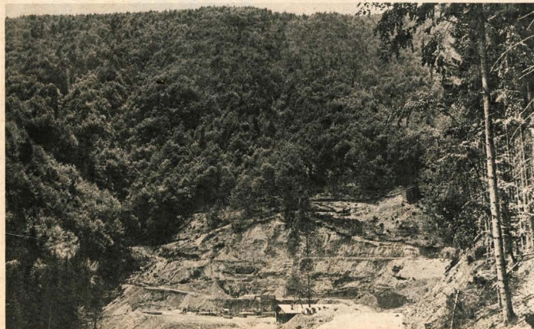
Delovna plosčad in del nove dovozne ceste
