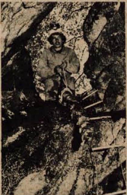
Brez improvizacije seveda ne gre: Stane Česnik po vrvi spušča v jašek lesen kol, s katerim bodo njegovi tovariši podprli krhlike apnenčaste skale in preprečili nevarno padanje skal.
