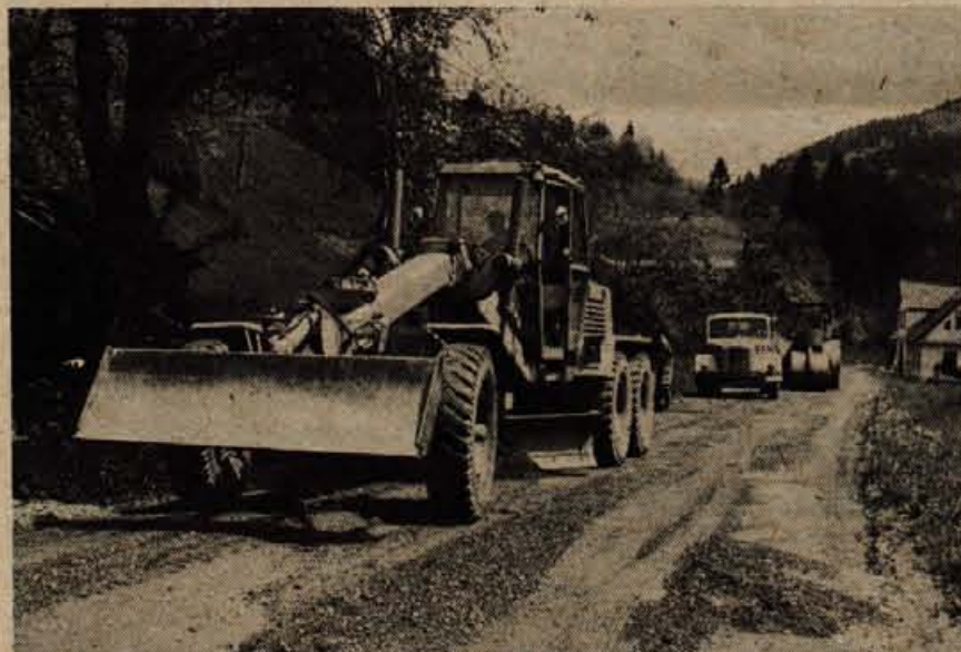
V preteklih dneh so delavci Cestnega podjetja Kranj obnavljali cesto na odseku Trebija—Sovodenj v Poljanski dolini. Mahadamsko cestišče, ki je bilo spriču zime in raznih vremenskih nepravil na nekaterih mestih močno načeto in luknjasto, so izravnali. Obnavljanje sodi v vrsto rednih vzdrževalnih del. (—jg) — Foto: F. Perdan
