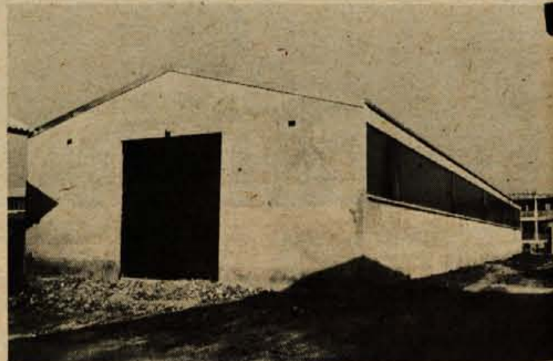
Proizvodna hala za steklarstvo Kranj — Primskovo
