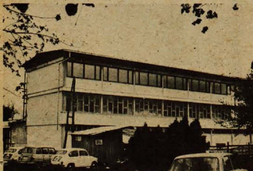
Komunalno gradbeno podjetje GRAD Bled pravkar zaključuje dela na prenovljeni stavbi blejske Vezanine.
