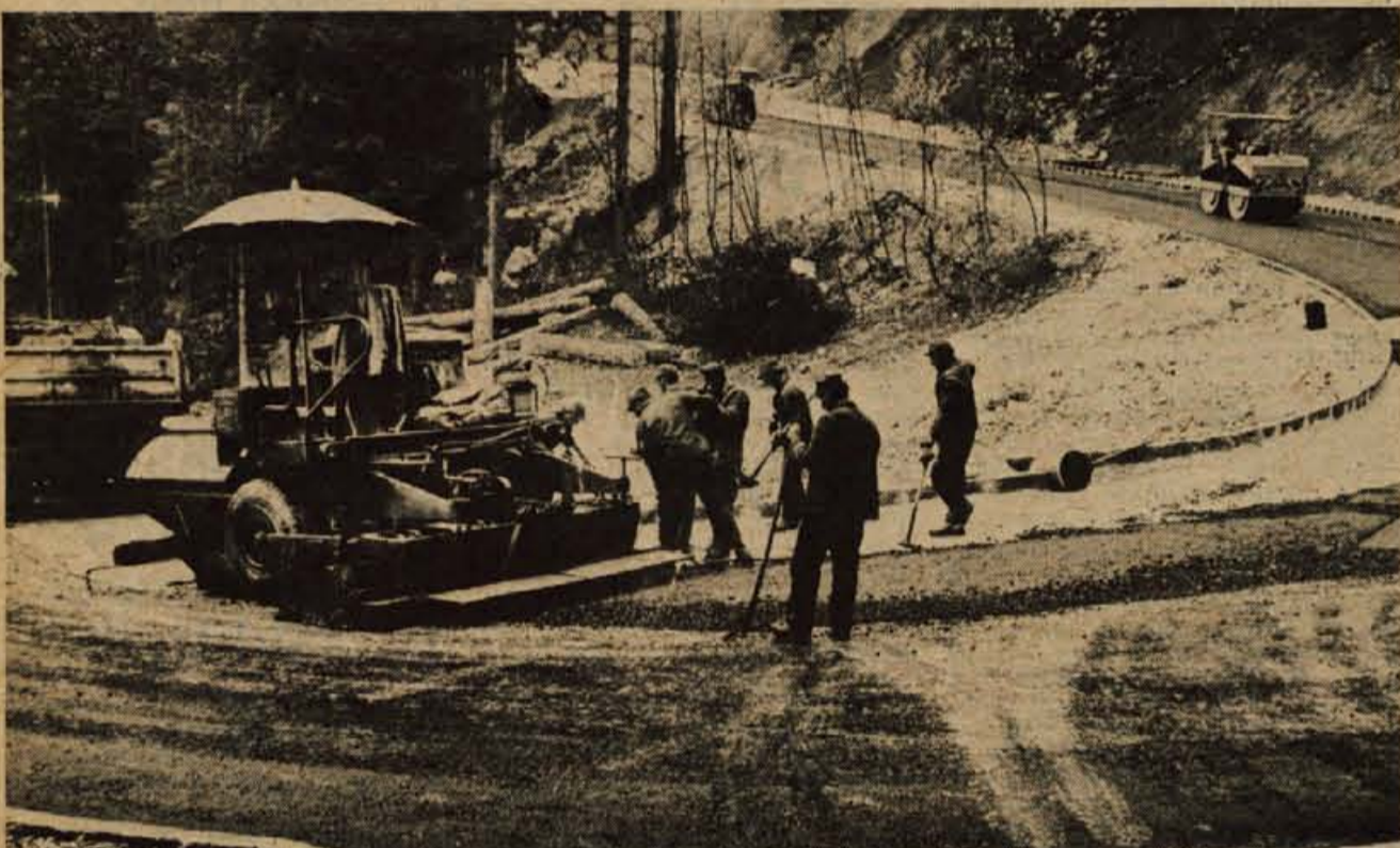
NA GOLICO PO ASFALTIRANI CESTI — Če ne bo slabšega vremena ali drugih nevarnosti, bodo delavci Cestnega podjetja iz Kranja danes ali jutri vgradili asfalt na 600 metrov dolgem odseku ceste v Jeseniški Rovi oziroma na Planino pod Golico. Tako bo asfaltiran najbolj strm in nevaren odsek poti v ta prijeten konec jeseniške občine. Zemeljska dela je opravilo podjetje Kovinar z Jesenic. (jk) — Foto: F. Perdan
