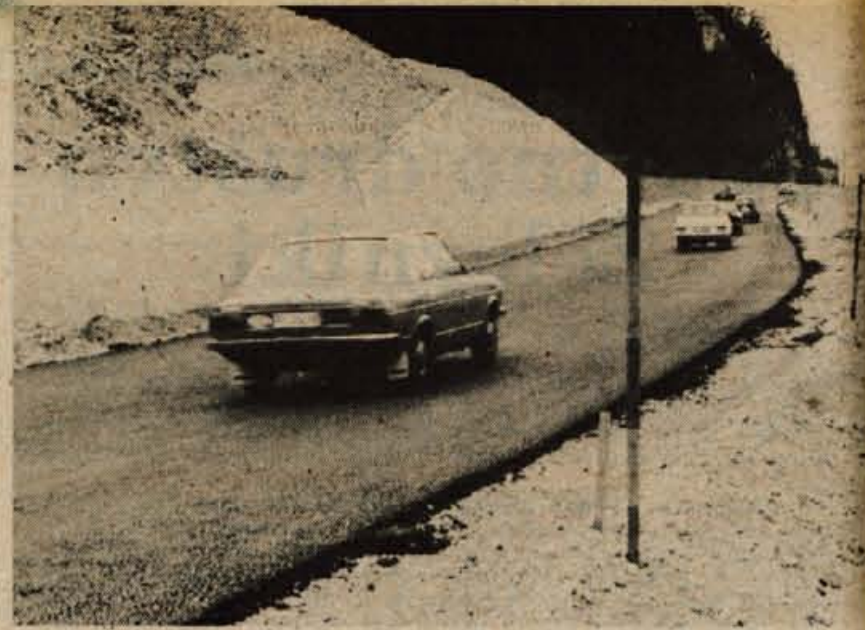
Konec prejšnjega tedna so delavci Cestnega podjetja Kranj položili asfaltno plast na novi del rekonstruirane ceste skozi Sotesko med Potoki in Koroško Belo. S tem so v glavnem odpravili ostre ovinke skozi ta najbolj problematični del glavne gorenjske ceste od Kranja do Koroške Bele. Delo, ki so ga opravljali delavci GIP Gradis, SGP Sava Jesenice, Zavoda za geodetske raziskave Ljubljana in Cestnega podjetja Kranj, je bilo tu zelo težko zaradi ozkega in majhnega prostora v Soteski, kjer tečeta železnica, cesta, spodaj pa je velik prepad proti umetnemu jezeru hidrocentrale Moste. Delavci Cestnega podjetja bodo tu uredili še odbojne ograje in bankine. Predvidevajo, da bodo s tem končali do konca maja, ko bo ta del glavne gorenjske ceste povsem urejen. — Foto: B. Blenkuš
