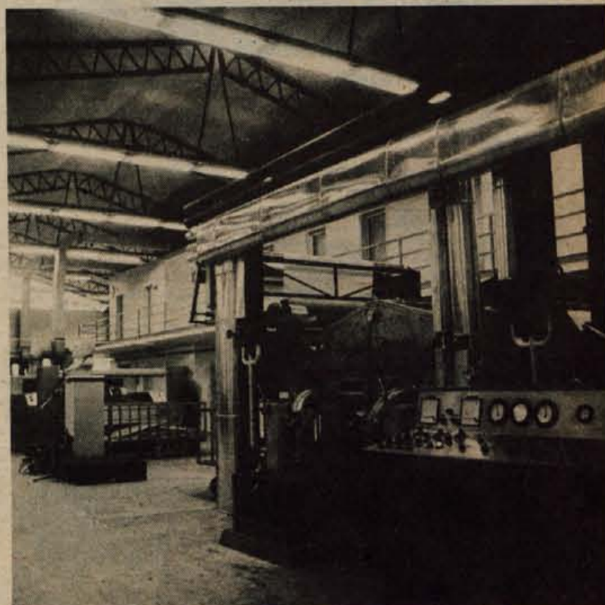
Širinski pralni stroj in razpenjalni sušilni stroj v plemenitilnici blaga
