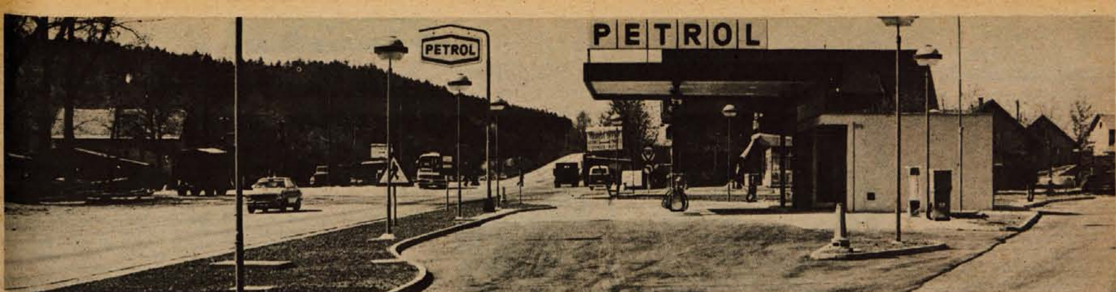
Podjetje Petrol bo v nekaj dneh odprlo novo bencinsko črpalko v Naklem. Graditi so jo začeli lani jeseni, gradnja pa bo veljala nekaj nad 2 milijona novih dinarjev. — Foto: F. Perdan
