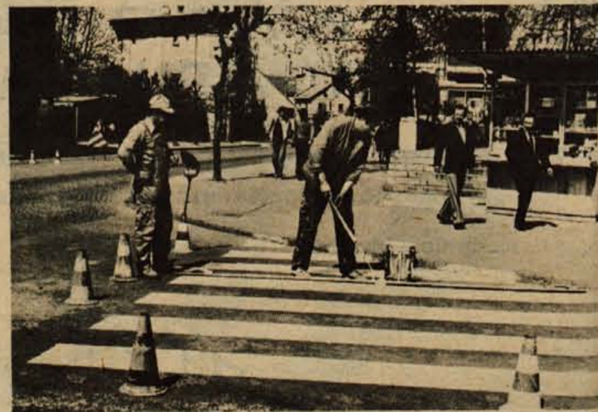
Te dni so se spet belo zableščale oznake na vozišču po kranjskih ulicah in prekrile že popolnoma od zime in avtomobilov zbledete prehode za pešce. — Foto: F. Perdan
