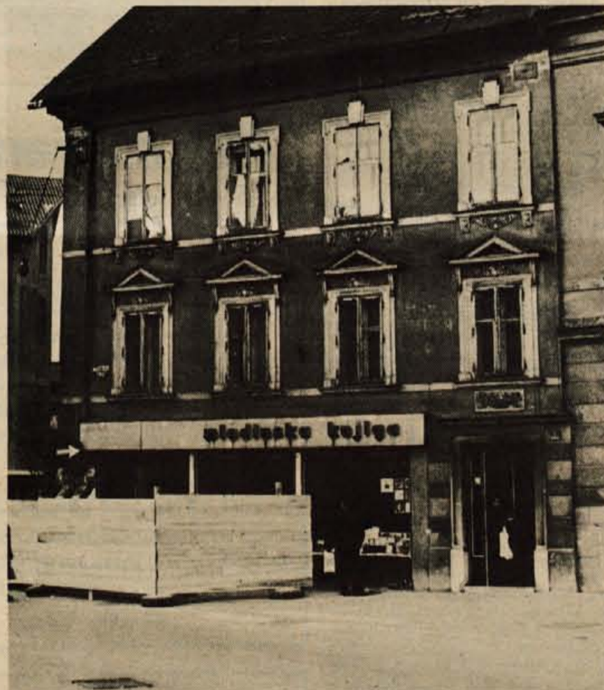
Na podlagi načrta o dokončni ureditvi Gregorčičeve ulice v Kranju je obrtno podjetje Cerklje ta teden začelo graditi arkadni prehod za pešce med Maistrovim trgom in Gregorčičevo ulico. Ureditev tega dela financira kranjska občina, predvidevajo pa, da bodo dela končana do 1. maja. — A. Ž. — Foto: F. Perdan
