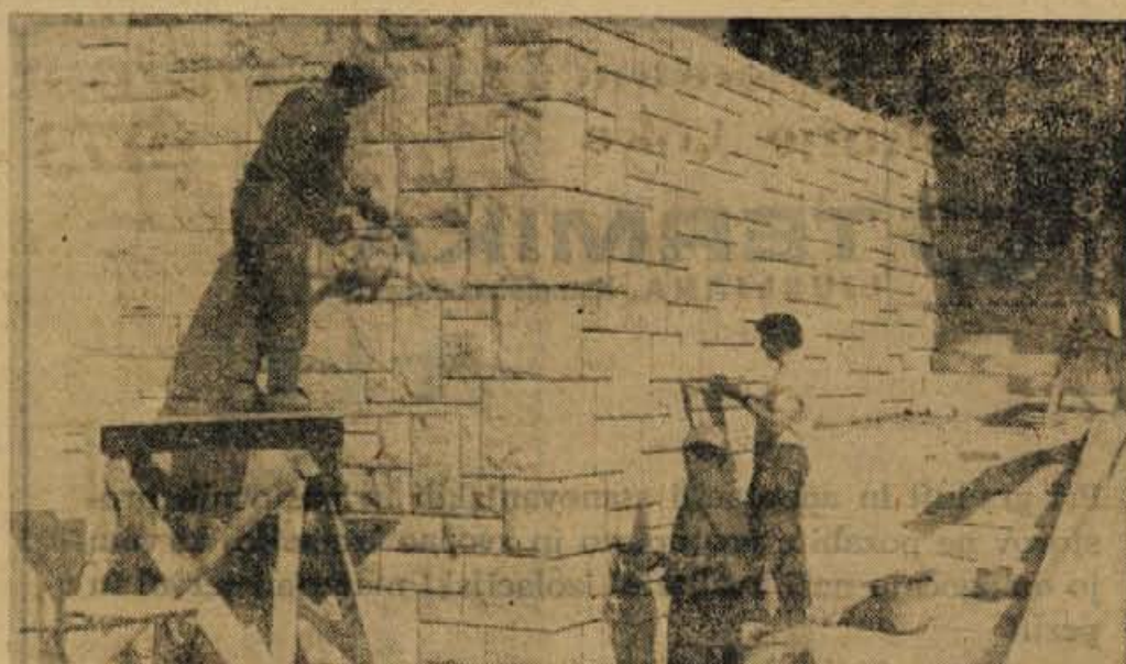
Hotaveljski kamnoseki pri montaži
