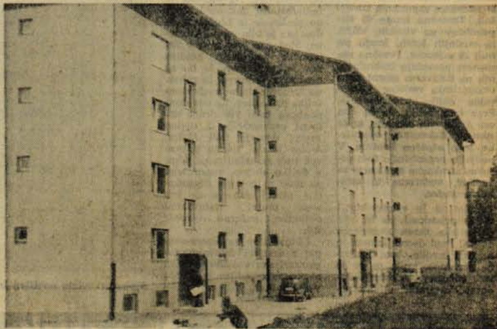
Stanovanjski blok v Medvodah so delo SGP Tehnik iz Škofje Loke
