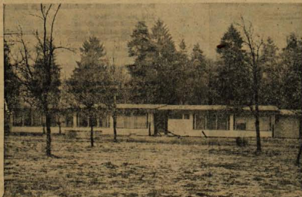
Novi vrtec na Trati pri Skofji Loki
