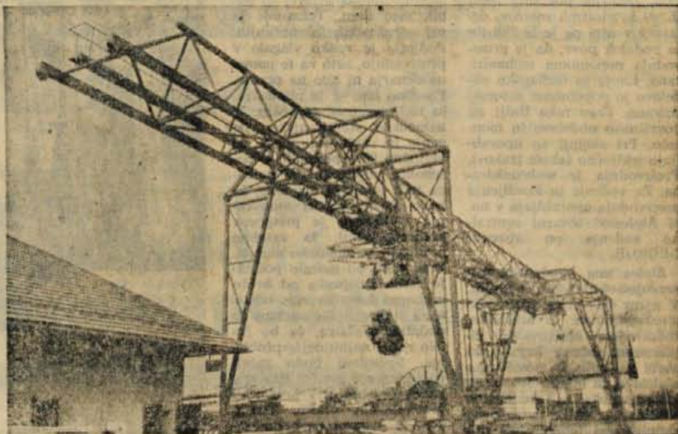
Portalni žerjav v Gradisu
