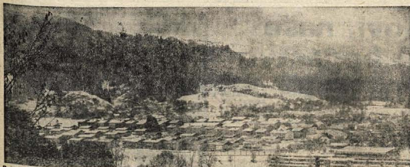
Puščobna sivina in uniformiranost sta glavni značilnosti mnogih na hitro in s čim manjšimi stroški zgrajenih stanovanjskih četrti. Opevamo gručasta naselja, kakršne so postavljali naši dedje, hkrati pa mirno gledamo nastajanje »taborišč«. — Foto: F. Perdan.
