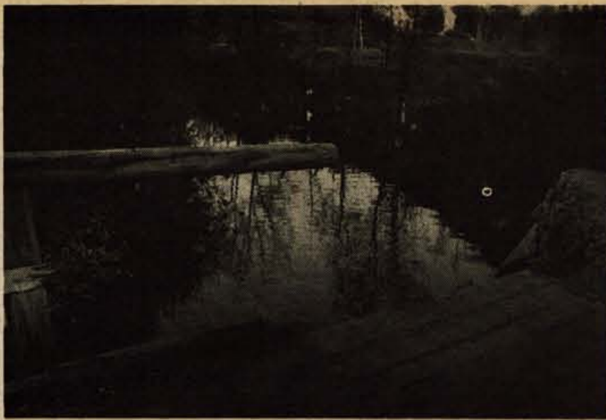
Kranjska TRIM steza je bila odprta za letošnji dan mladosti in teče v glavnem po gozdu v bližini Ovcana. Na severnem delu mora strimovec prek mostu čez potok Rupenščica. Most je že nekaj časa brez dobrega dela zaščitne ograje (na fotografiji). Da se je ograja sesula kar sama, je bolj malo verjetno. Najbrž enemu od »ljubiteljev« trima številna zvirala ob progi očitno niso bila dovolj in je svojo odvečno energijo potrošil za podiranje ograje na mostu. (jk) — Foto: F. Perdan
