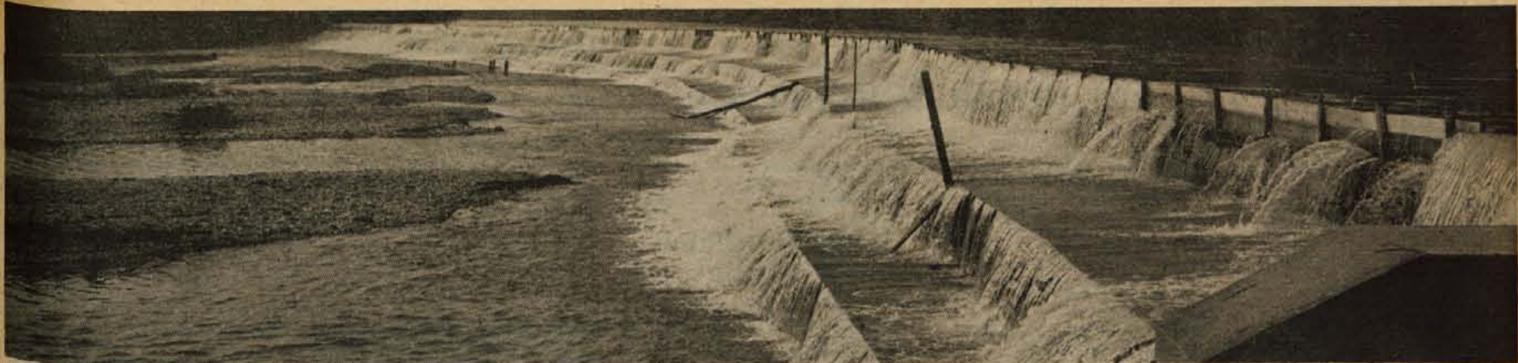
V okviru regulacije Save v kranjski občini je predvidena tudi rekonstrukcija jezusa pri Tekstilindusu. Jez je v glavnem dotrajan, zato bodo obnovili temelje in zgornjo konstrukcijo. Novost pa bo posebna plastična naprava, ki bo uravnavala nivo vode. Obnova bo veljala več milijonov dinarjev. — Foto: A. U.
