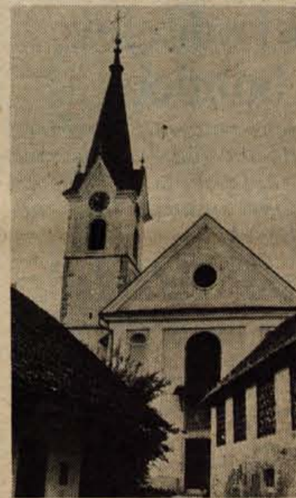
Cerkev Janeza Obglavljenega na Zgornjem Brniku. Vidna je njena utesjenost med vaškimi hišami.
