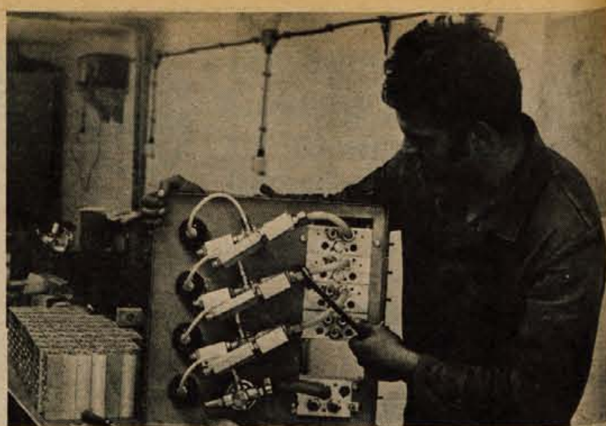
Montaža krmilne plošče.
