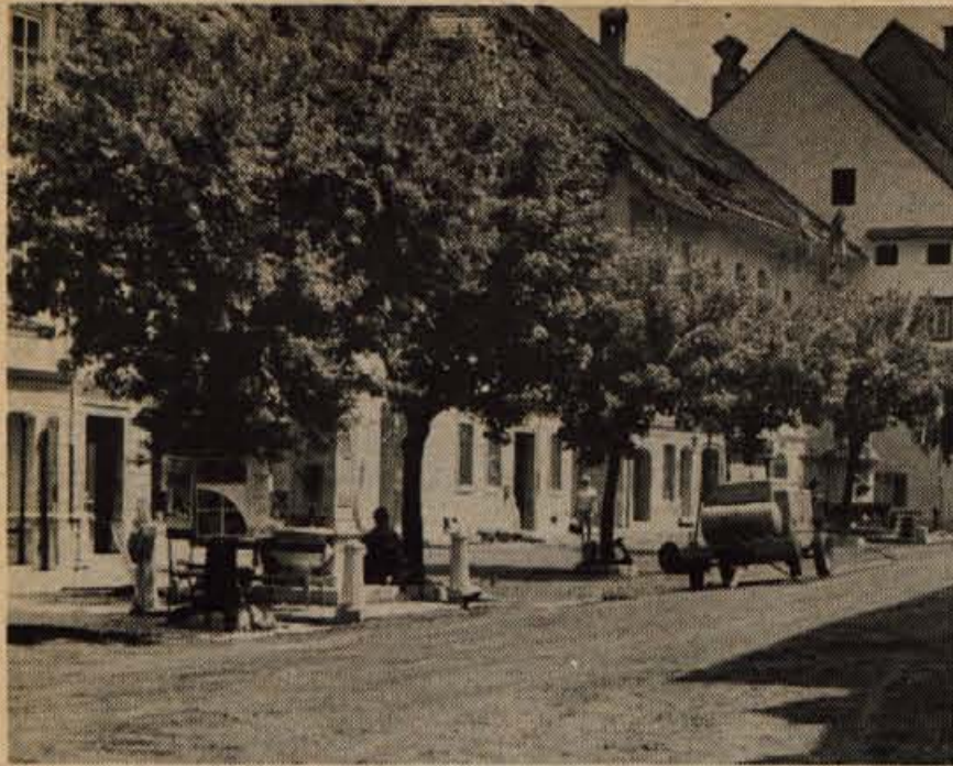
Domiselno preplekane fasade hiš na Mestnem trgu in nove stilne luči, naslednice neprijaznega neona, so staremu jedru Loke vtisnile priokus srednjeveške romantike. Človek kar pozabi, da se pod pravkar nanesenim asfaltnim plaščem skriva mreža najmodernejših vodovodnih in kanalizacijskih cevi ter električnih kablov. (-ig) — Foto: A. U.
