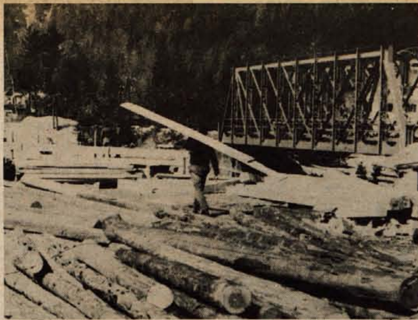
Delavci SGP Sava z Jesenic grade nov betonski most čez Pišenco v Kranjski gori. -- Foto: B. B.
