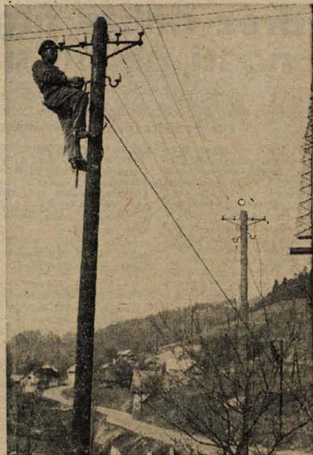
Pričujočo fotografijo smo posneli ob cesti v Poljansko dolino, kjer ekipa monterjev podjetja Elektro Kranj pregleduje meter za metrom dragocenega bakrenega »ožilja«. Možno spretno napenjajo povešene žice ter jih, če je potrebno, zamenjujejo z novimi. Obenem utrjujejo nosilne drogove, prek katerih bodo do Gorenje vasi in Zirov v kratkem speljali debel večsmerni kabel, odporen proti vsem vremenskim nevarnostim. »Dolincem« se torej obetajo svetlejši časi z mnogo redkejšimi izpadli električnega toka. (ig) — Foto: F. Perdan
