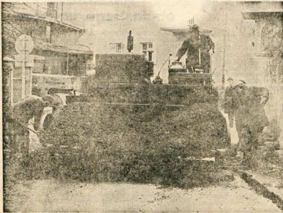
Cestno podjetje Kranj je v zadnjih nekaj dneh v Kranju asfaltiralo nekatere ulice. Med drugim je asfaltiralo tudi makadamski del Partizanske ceste (od križišča z Gregorčičevo ulico do križišča s cesto Staneta Žagarja). — A. Z. — Foto: F. Perdan
