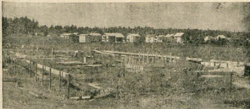
OSNOVNA SOLA KOKRICA — Gradi jo podjetje Gradis Ljubljana — poslovna enota Jesenice. Rok izgradnje je 1. avgust 1973. Glavni dohod z vzhodne in peš pot z zahodne strani bosta asfaltirana.
