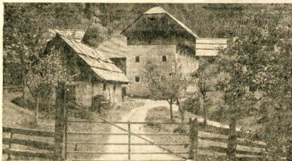
Jenkova kosarna na Zg. Jezerskem. Zgodovinska stavba je služila kot hospic (gostišče in prenočišče) že v 16. stoletju. — Foto: F. Perdan
