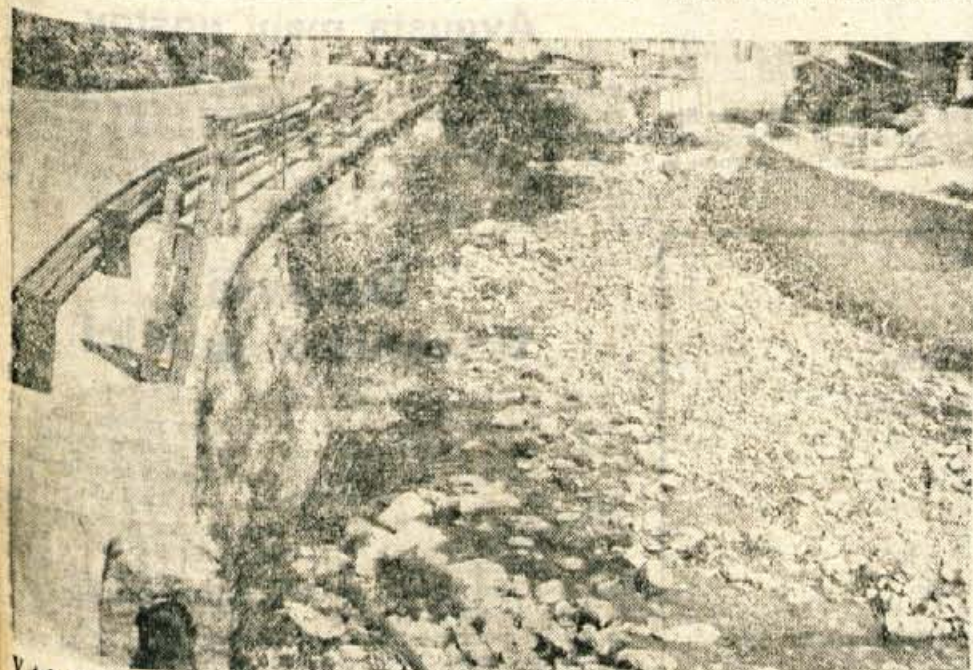
V teh dneh končujejo dela pri gradnji obrežja Sore od jezua na Trnju do mostu pri kulturnem domu. — Foto: F. Perdan
