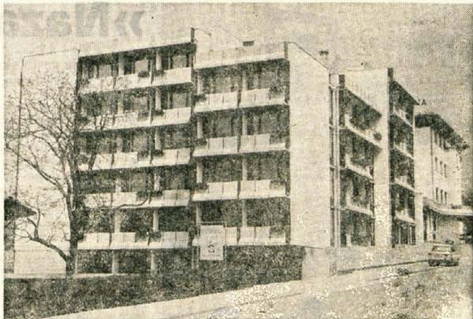
Med 18 hotelskimi objekti, ki jih je zgradilo splošno gradbeno podjetje Gorenjc iz Radovljice, je tudi hotel Krim, ki je bil odprt letos.
