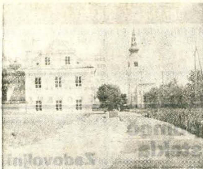
Stara osnovna šola v Gorjah, prenovljena v vzgojnovarstveno ustanovo. — Foto: J. Ambrožič
