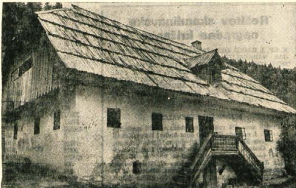
Izrazit jezerski kmečki dom — Krničarjeva domačija (Zg. Jezerjsko št. 104) pri starem Sv. Ožboltu. Hiša je še krita z macesnovimi škodlami, ograja stopnišča je lepo izrezljana, zidan je le spodnji del. — Foto: F. Perdan
