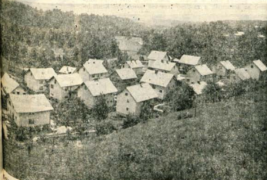
Občinska skupščina se je pred leti odločila, da se zazidalna površina v Logu pri Trzinu, ki je bila namenjena za zasebno stanovanjsko gradnjo. Površina je sedaj pozidana. Kljub temu, da se vsi graditelji niso držali gradbenih načrtov, je naselje v Logu vseeno med najlepšimi v tržiški občini. (k) — Foto: F. Perdan
